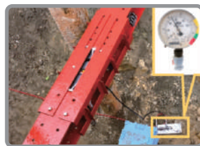
ジャッキからメーターを有線で接続
