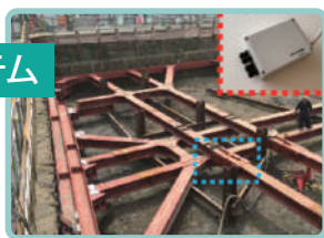
土留壁を抑える油圧ジャッキに IoT機器を接続
